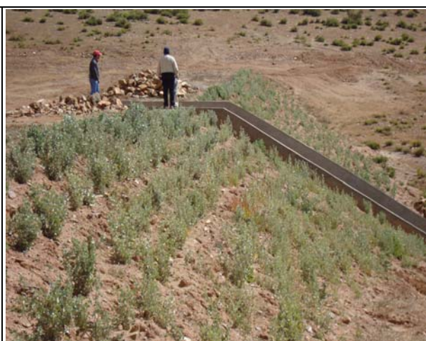
La sp piragua con la función de proteger los taludes de las presas de tierra.
