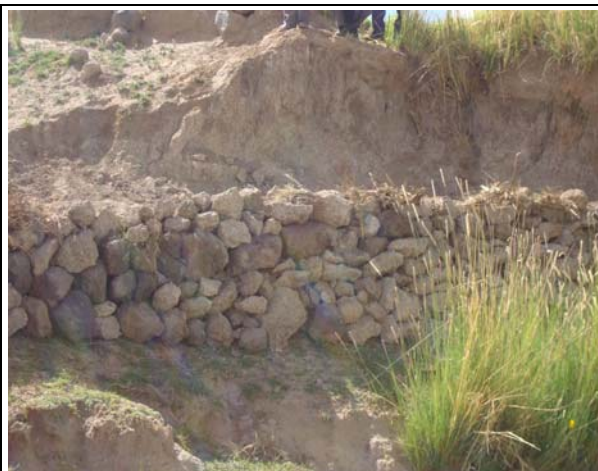
Nuevas construcciones de terrazas.
