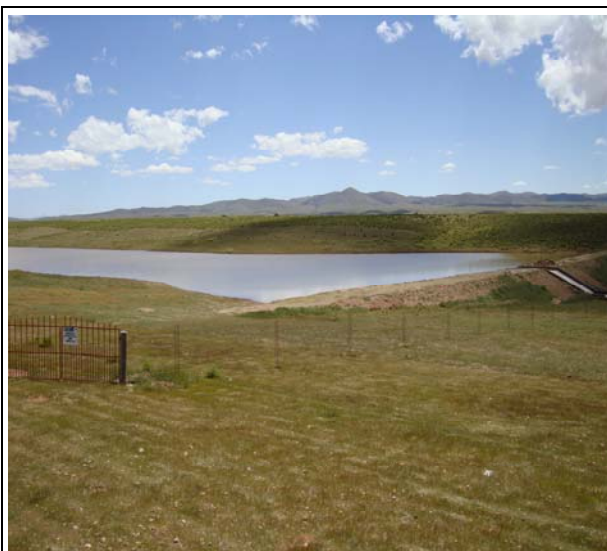
Presas de tierra con una capacidad de almacenamiento de 30000 m 3
